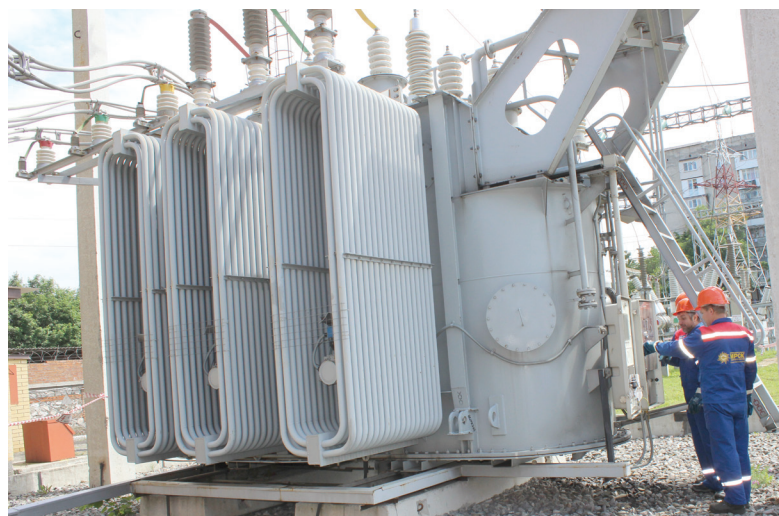
Текущий ремонт силового трансформатора на подстанции «Северо-Западная» 110-6 кВ, которая обеспечивает электроэнергией микрорайон во Владикавказе. Всего до конца 2017 года энергетики филиала МРСК Северного Кавказа – «Севкавказэнерго» отремонтируют 55 силовых трансформаторов
