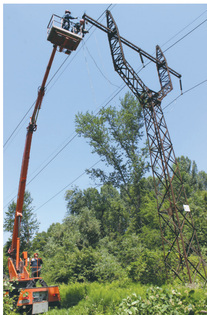
Ремонт ВЛ-110 кВ № 111 «Змейская-Эльхотово» в Северной Осетии. Ремонтные работы на высоковольтных линиях электропередачи повысят надежность электроснабжения потребителей
