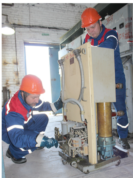
Ремонт масляного выключателя 6 кВ на подстанции «Западная» 110-6 кВ обеспечит надежным электроснабжением Республиканскую клиническую больницу Северной Осетии
